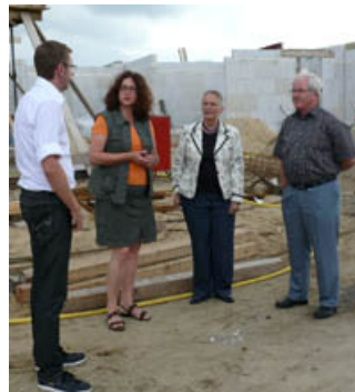
Auf der LeA-Baustelle.
